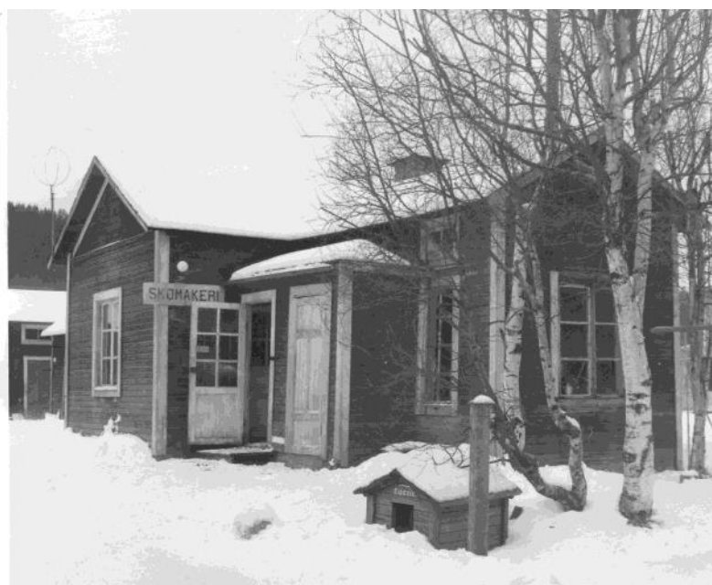
Skomakeriet på N.Ådalsvägen 57. Foto i Lennart Norströms ägo.
