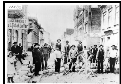
Arbetslag som genomför vägarbeten på Storgatan
